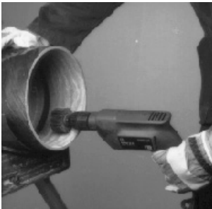
Dépolissage de l'embout femelle (tulipe)
