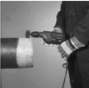
Dépolissage de l'embout mâle
