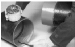
Application de la colle
